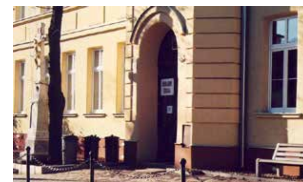
Změna vzhledu fasády po opravách v roce 1997
