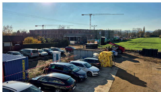
Pohled na DPS od budovy DYHA
