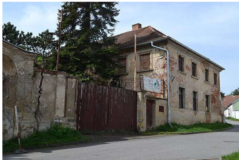
Obr. 6: Budova bývalého firemního sídla.
