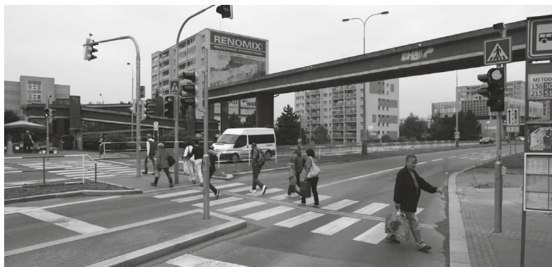
[OBR. 12] Nevhodně řešené mimoúrovňové křížení pěšího pohybu s komunikací. Pro nefunkčnost byl nejprve paralelně zřízen úrovněvý přechod a nakonec nadchod zcela odstraněn.
