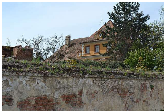
Obr. 3: Pohled na zámeckou budovu
