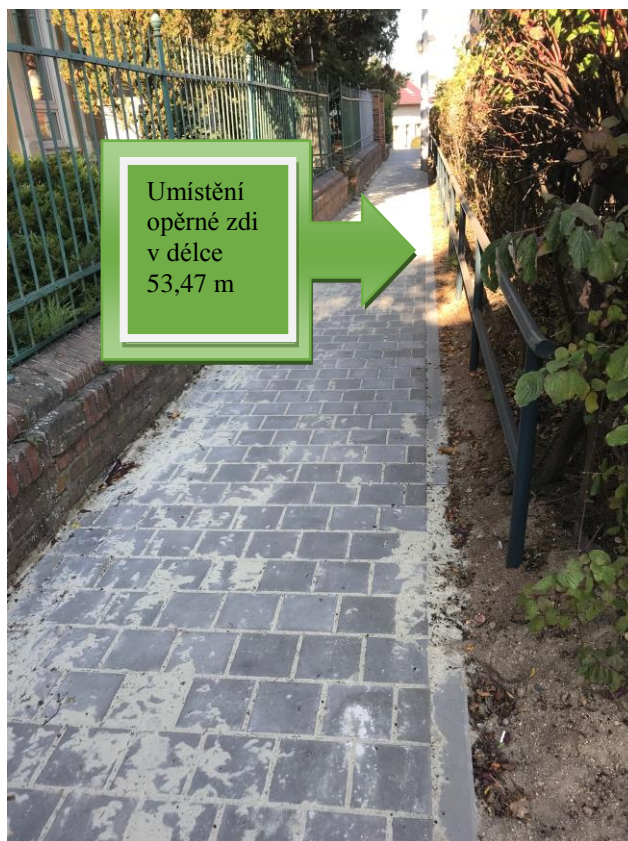
Obrázek 7 - Umístění opěrné zdi
