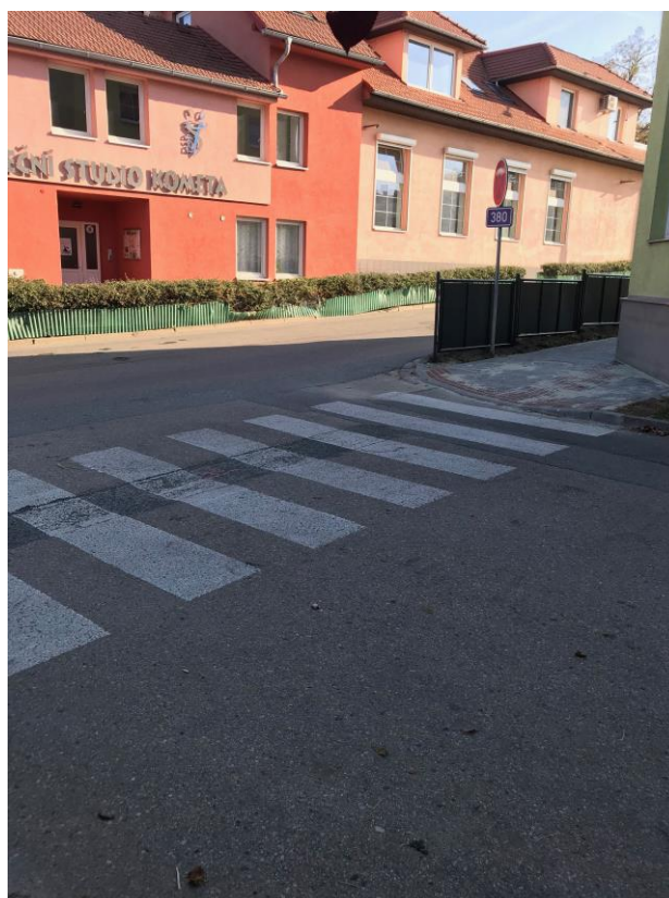
Obrázek 6 - Stávající nevyhovující přechod pro chodce
