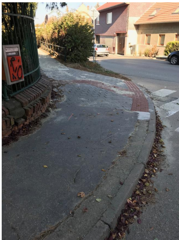
Obrázek 5 - Stávající stav chodníku
