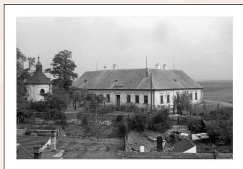
Stará školní budova z roku 1872. Vlevo poutní kaple Panny Marie postavená kolem roku 1730.
