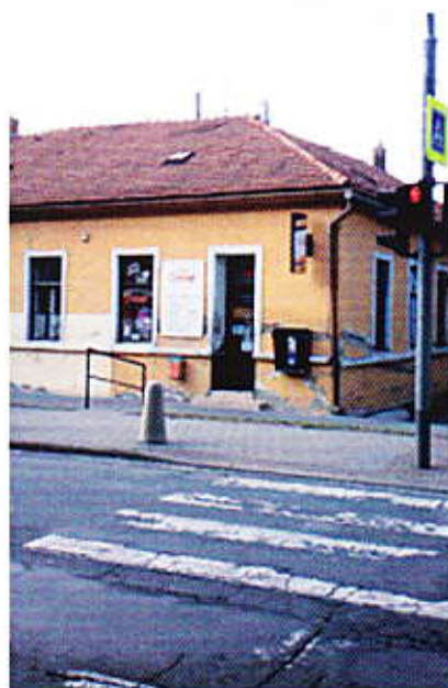
Zchátralá budova pekárny
