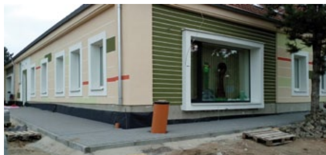
Fasáda školky v průběhu prací v srpnu 2016
