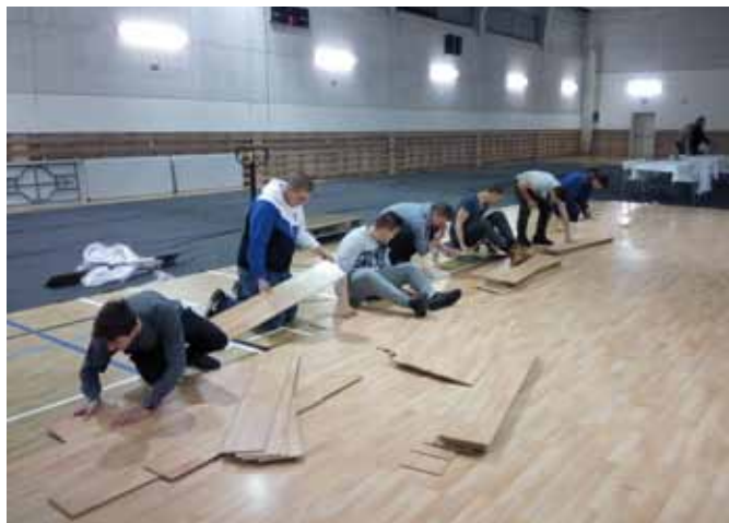
Příprava sálu pro obecní ples zahrnovala i instalaci rozebiratelného tanečního parketu, který chránil původní hrací plochu tělocvičny.
