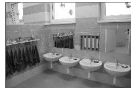
rekonstrukce soc. zař. MŠ U Lípy Svobody
